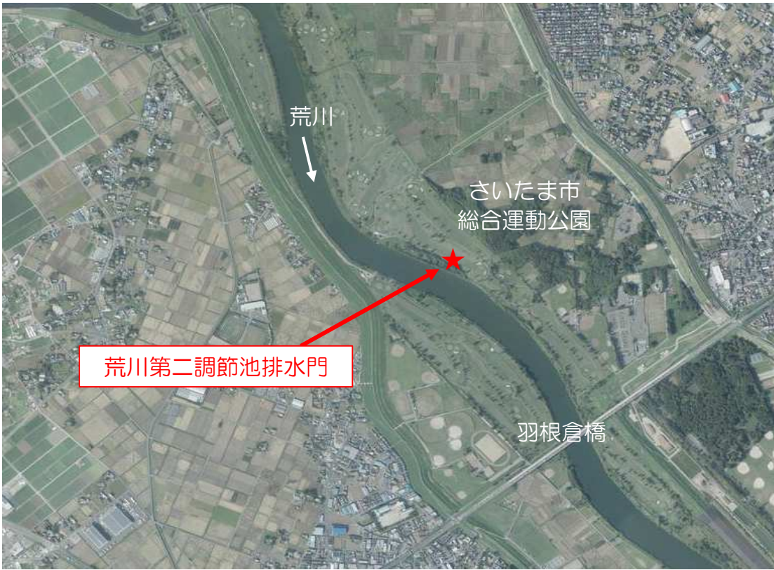
荒川第二調節池排水門周辺の航空写真 ※出典：国土地理院HPよ
