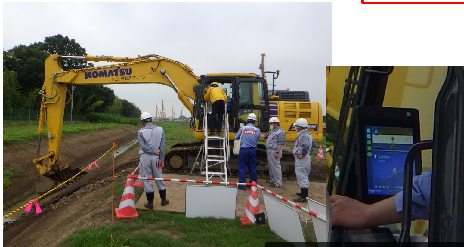
ICT機器を用いたの施工体験状況
