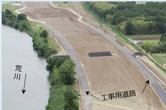
工事完成時の写真 (R4.5撮影)
