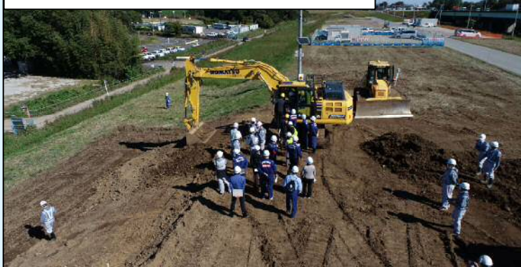
ICT機械体験会イメージ（羽根倉橋左岸上流）
