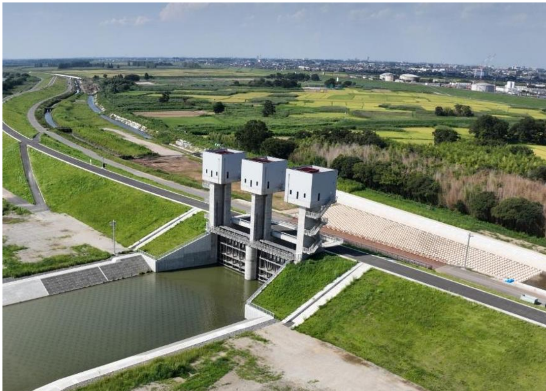
荒川第二調節池排水門
