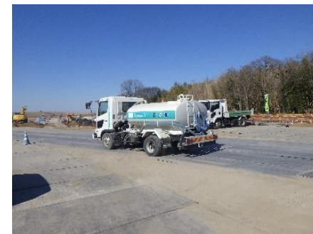
粉じんの飛散軽減のため散水の実施
