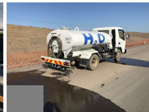
粉塵の付着状況の確認、散水状況
