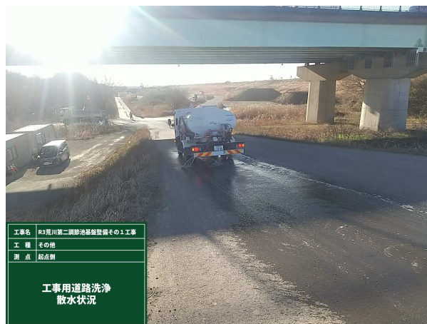
工所用道路での散水状況 (令和4年1月31日撮影)
