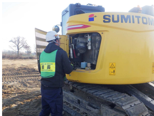
建設機械の点検状況 (令和4年1月27日撮影)
