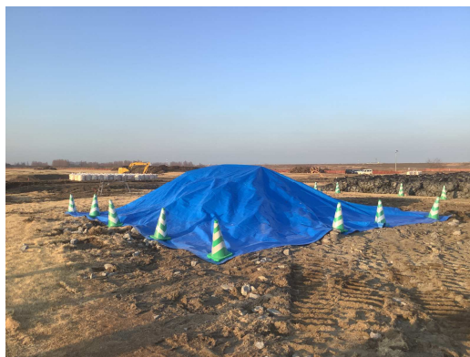
資材への被覆シート設置状況 (令和4年1月26日撮影)
