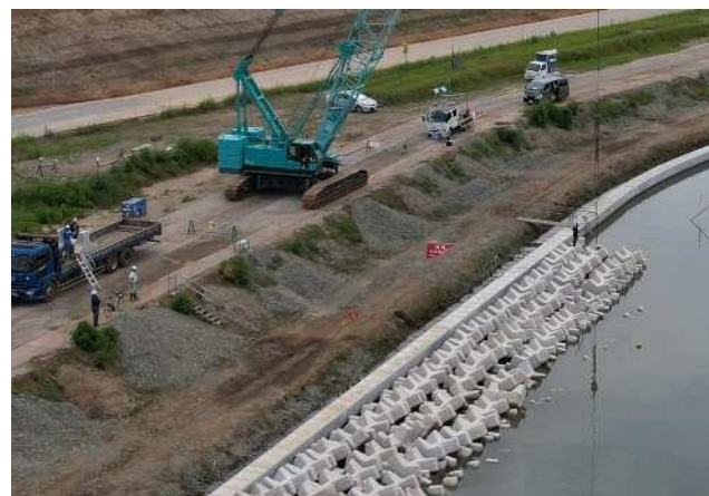
根固めブロック施工状況イメージ
