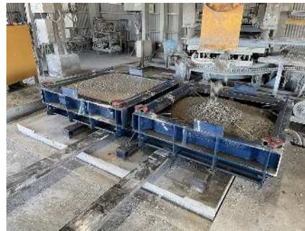
連結ブロック製作（Co打設）状況
