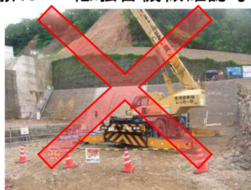
排ガス・低騒音機械確認写真
