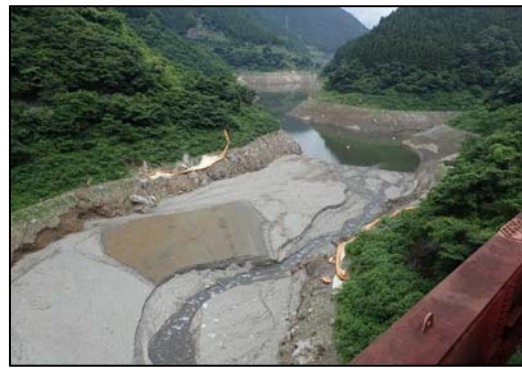
浦山大橋下流 (H29. 7. 28)
