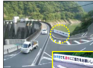
荒川二瀬ダム天端
