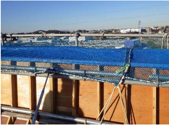
養生マットに飛散防止ネットを設置
