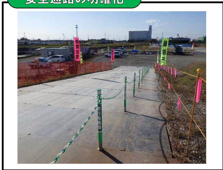
ポール及びチェーンを用いた安全通路の設置
