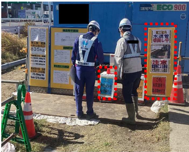
写真付きの看板等を用いて埋設位置の明示
