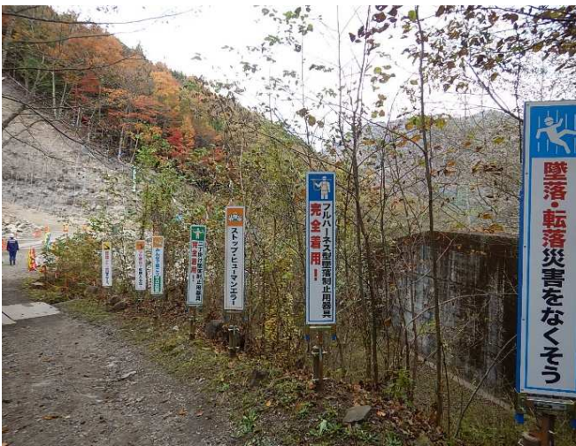
現場事務所から作業場所に至るルート上に 注意喚起・安全啓発看板を設置
