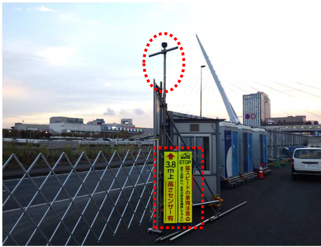
高さセンサー、注意喚起看板の設置
