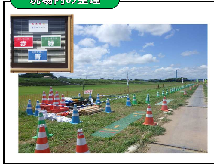
カラーコーンの色分けで、 立入禁止 (赤) ・安全通路 (緑) ・資材置場 (青) を明示
