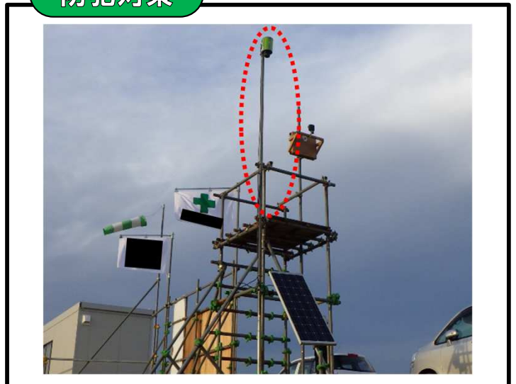
防犯カメラを設置
