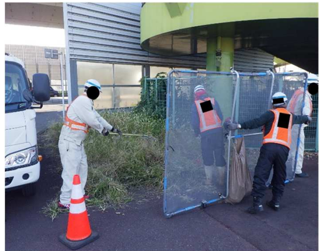
飛散防止ネットの使用
