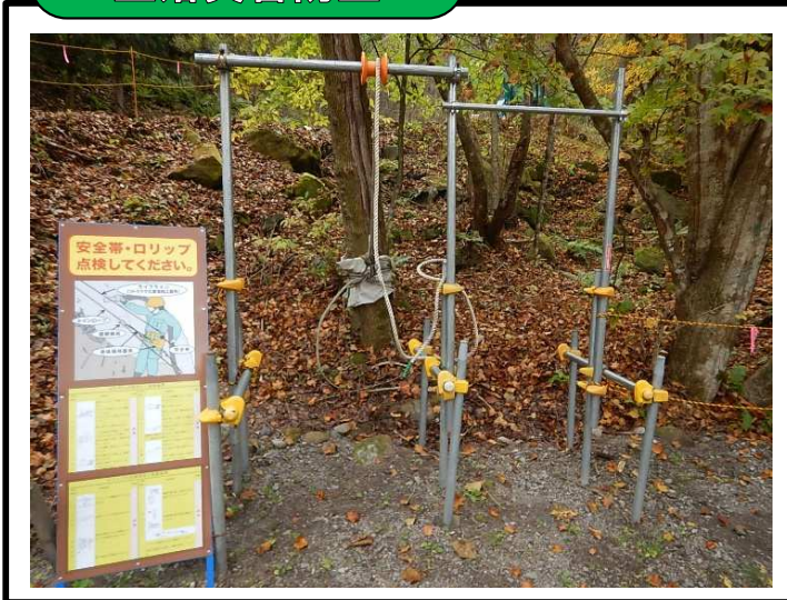
安全帯・ロリップの事前点検コーナーを設置
