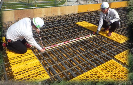
鉄筋ピッチ検測
