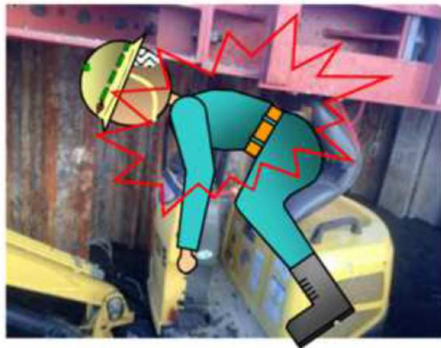
操作を誤り、土留支保とバックホウの間に挟まれた事案
