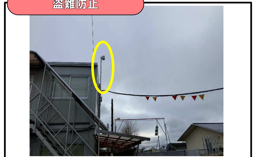
現場内での監視カメラの設置
