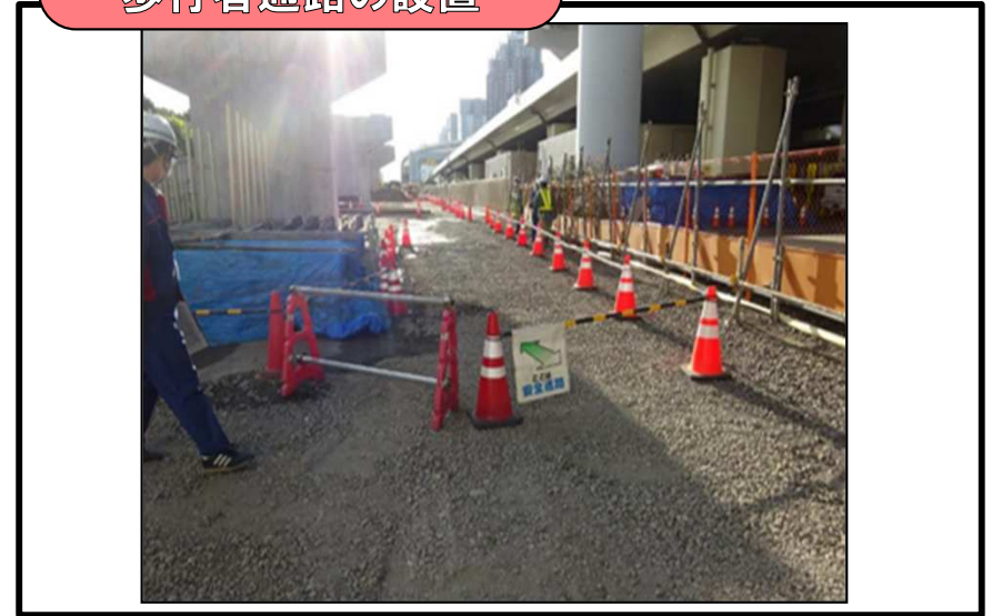
コーンバーを設置し、通路の“見える化”
