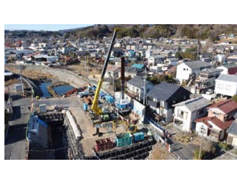
【鋼管杭を回転切削圧入中。】 撮影者会社名・撮影者：前橋地建(株) 堀電弘幸
