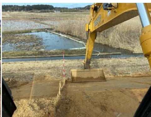
【オペレーターの視界】 撮影者会社名・撮影者：藤枝建設(株) 藤枝賢一
