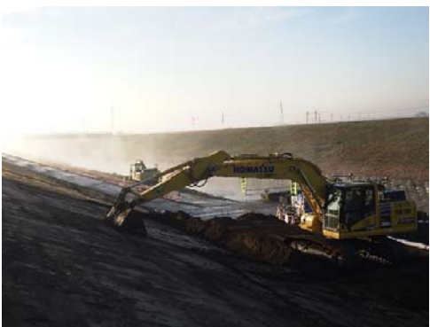
【MCバックホウ！朝からフル稼働！】 撮影者会社名・撮影者：中村土建(株) 小野口謙
