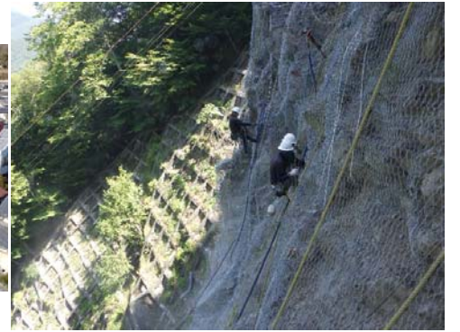
【垂直斜面もなんのその】 撮影者会社名・撮影者：松本土建(株) 輪湖栄二
