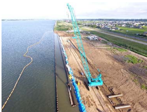
【川の中へ鋼矢板を打設中！】 撮影者会社名・撮影者：岡田土建(株) 石毛龍介
