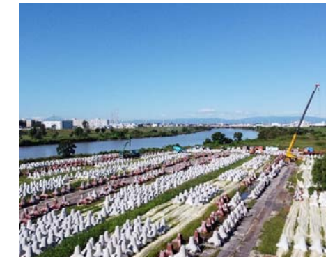
【根固めブロック製作中】 撮影者会社名・撮影者：多田建設(株) 天戸雄介
