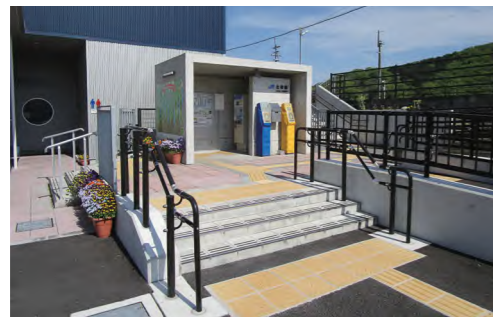
コンパクト化された太市駅の駅舎と隣接する民間企業のバリアフリートイレ
