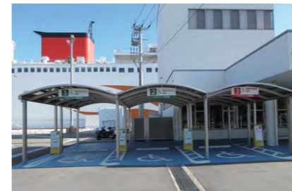
フェリーターミナル内 バリアフリー駐車スペース
