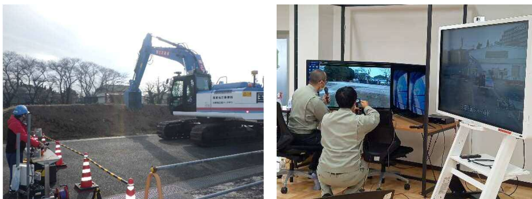
無人化施工Webセミナーの配信状況
