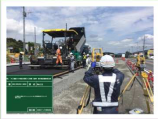
MCアスファルト フィニッシャー
