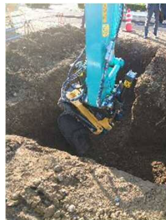
丁張りレスL字掘削
