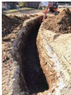
丁張りレス湾曲掘削
