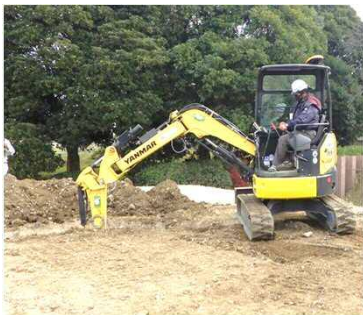
マシンガイダンスによる管路掘削
