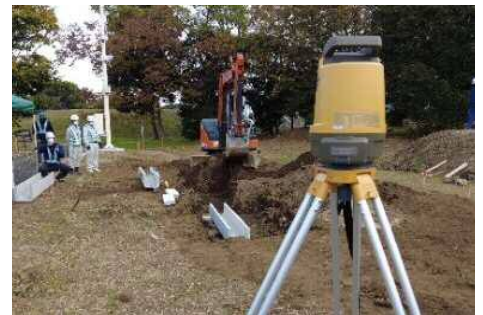
自動追尾TSを利用したU字溝の設置誘導
