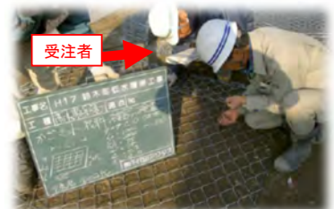
(河川護岸用かごマットの材料確認)
