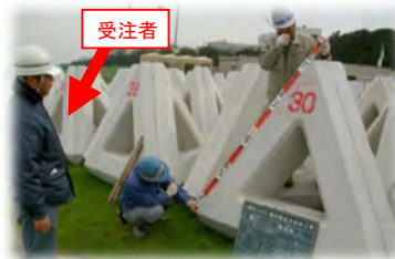
(根固めブロックの材料確認)
