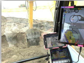
指定工種以外への積極的なICT活用 (写真は土砂改良工)
