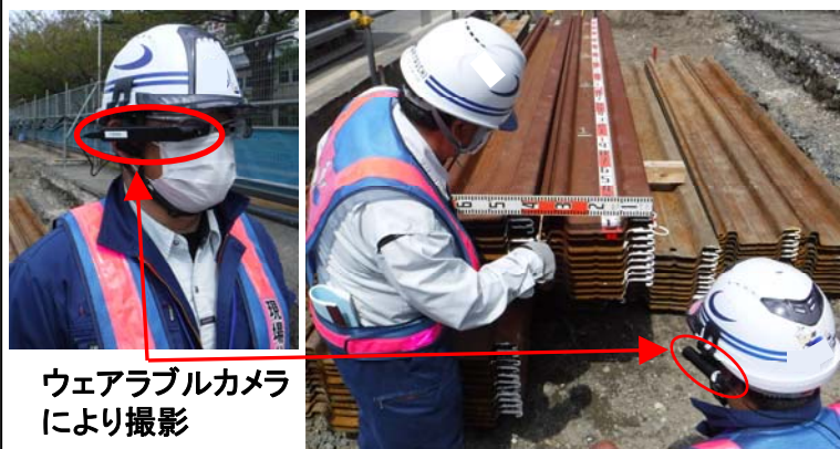
現場での受注者による撮影状況
