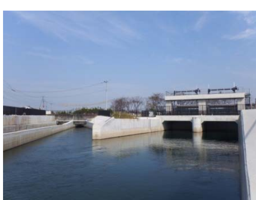
星川水門(新設)
