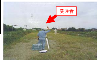
(現場状況の照合を実施)
