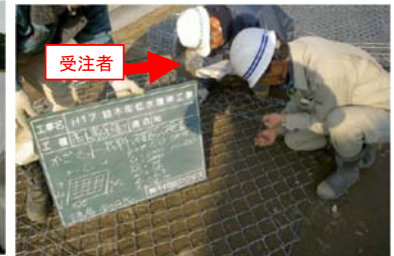
(河川護岸用かごマットの材料確認)
