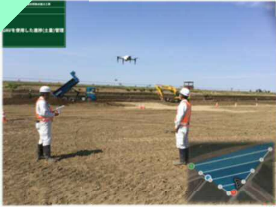
UAVによる日常的な測量・土量管理
