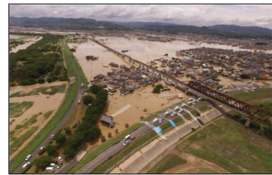
H30.7豪雨における浸水・排水状況 (岡山県倉敷市真備町)
