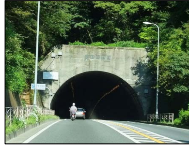
〈新善波トンネル L=0.260km〉
