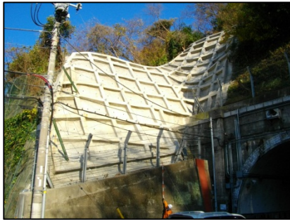
（国道16号横須賀市田浦町）
