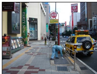
〈グレーチング蓋の確認〉
