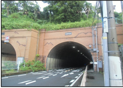
〈吉浦隧道 L=0.216km〉
