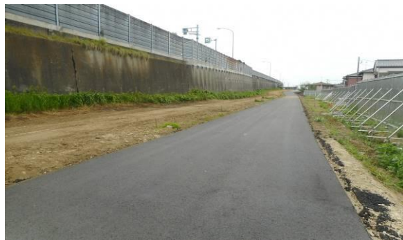
一般国道122号蓮田岩槻バイパス現地状況（仮設道路）（平成30年6月現在）
