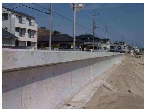
写真-2 復旧状況：金沢地区海岸（日立市）
