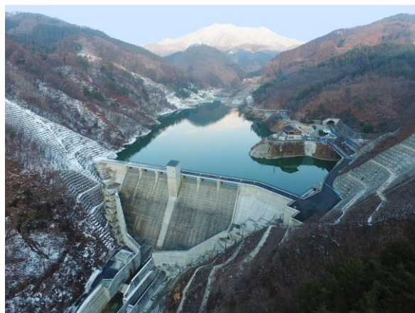
〈写真-2〉試験湛水状況写真
