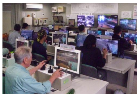
遠隔操作による無人掘削工事
