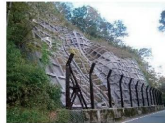
道路の落石対策
