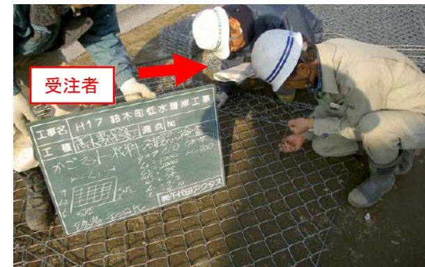
(河川護岸用かごマットの材料確認)
