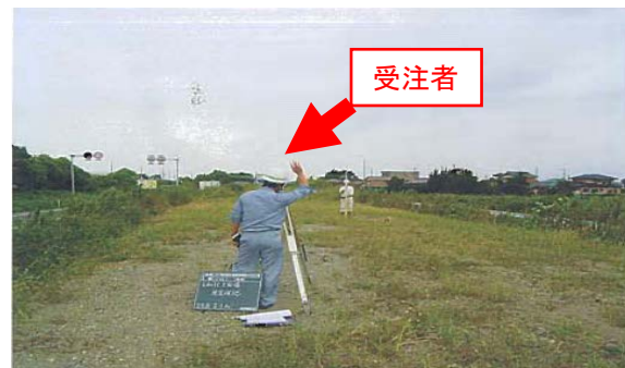
(現場状況の照合を実施)
