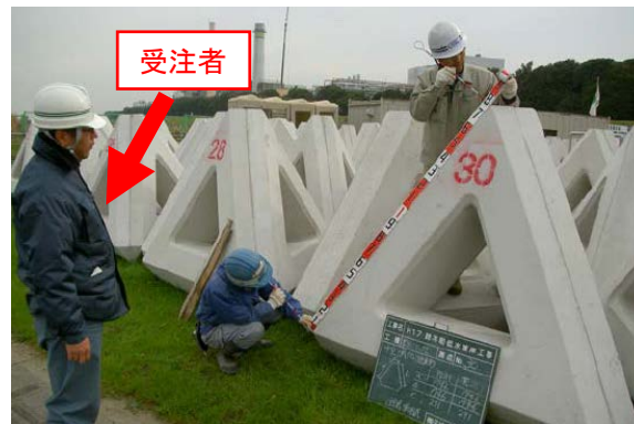
(根固めブロックの材料確認)
