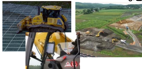
ICT建機での施工
