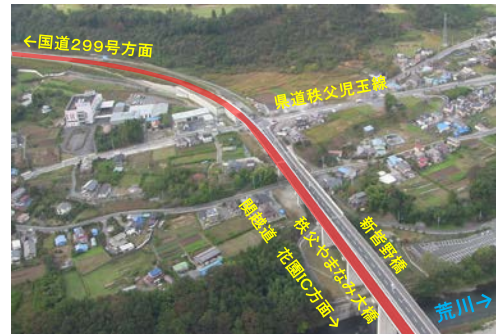
【写真1】秩父やまなみ大橋
