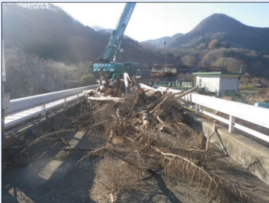
引き上げ状況
