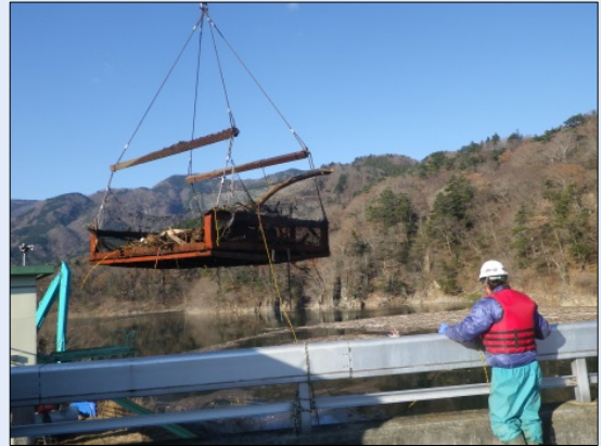
引き上げ状況
