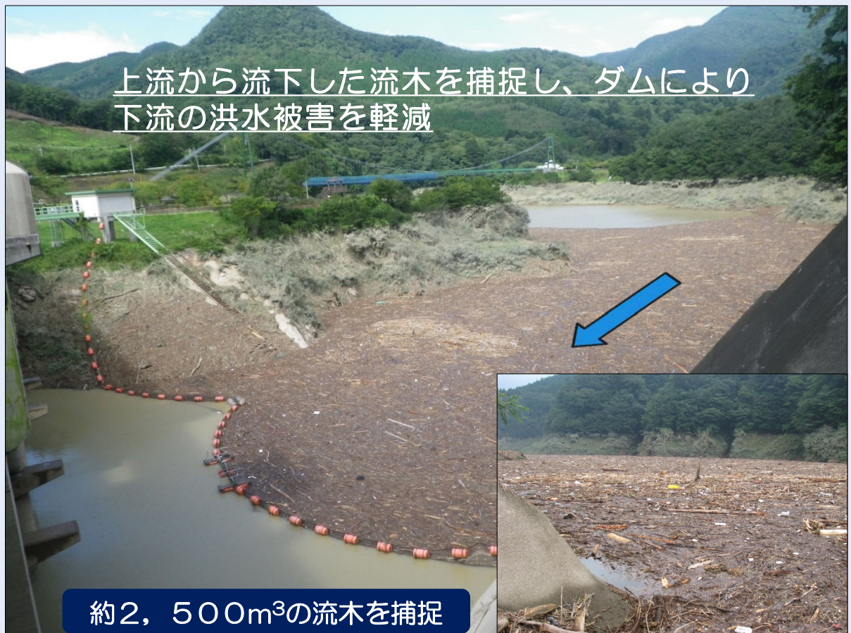
塩原ダムの流木捕捉状況
