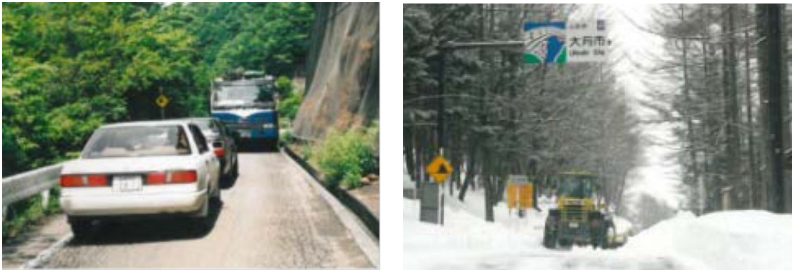
図2. 松姫峠（旧道）の現況
