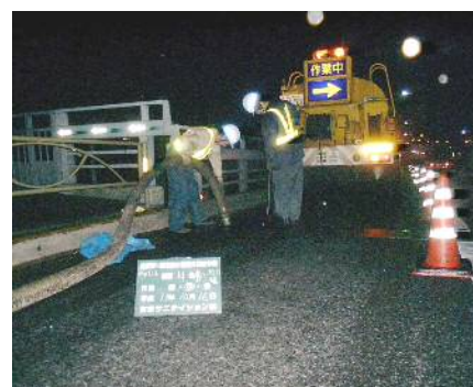
〈排水構造物清掃〉
