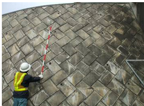
<擁壁の点検状況>
