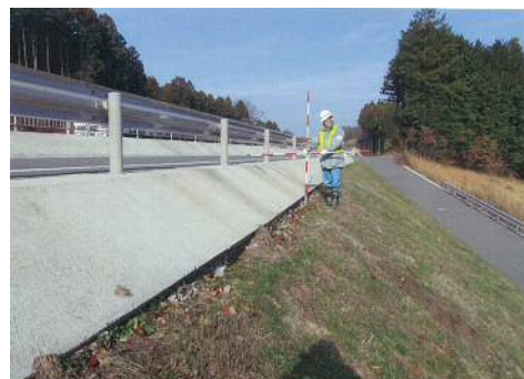
<法面の点検状況>
