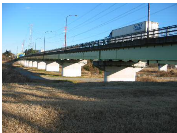
〈国道4号鬼怒川橋〉
