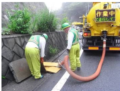
〈側溝清掃 (機械)〉
