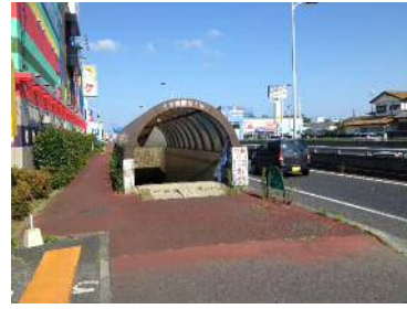
〈笠原地下歩道〉 (国道50号水戸市千波町)
