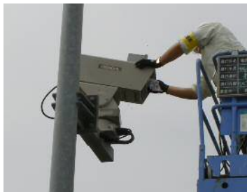
〈設備点検（CCTV）〉
