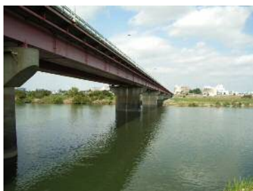
〈大利根橋〉 (国道6号利根川渡河部)
