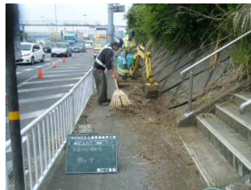
作業状況 〈歩道清掃〉
