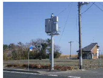
〈稲村橋 CCTV〉 (国道6号 高萩市安良川)
