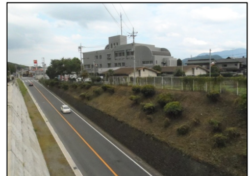
〈除草（法面）実施後〉
