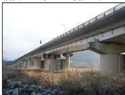
〈新早川橋〉 (国道52号 早川渡河部)
