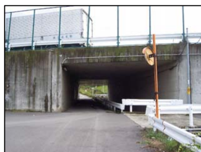
〈矢沢川地下道〉 (国道20号 甲州市勝沼町)
