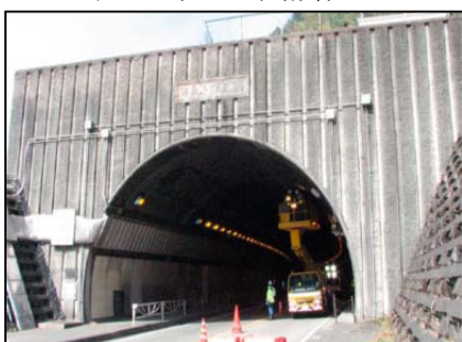
〈南部トンネル〉 (国道52号 南部町南部)
