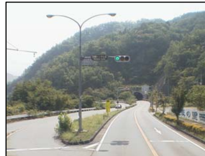
〈道路照明〉 （国道52号 富士川町鰯沢）
