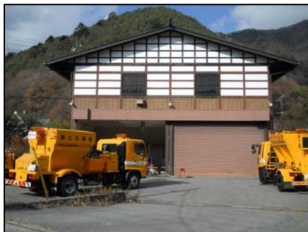
〈精進湖除雪ステーション〉 （国道139号 富士河口湖町精進）
