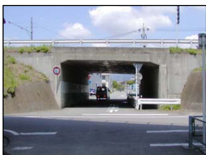
〈坪井インター地下道〉 (国道20号 笛吹市一宮町)
