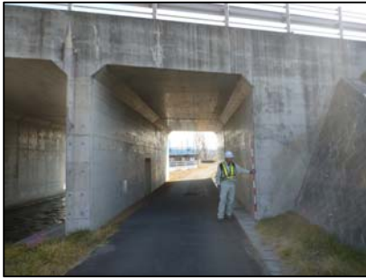
〈下今井地下道〉 （国道52号 甲府市下今井）
