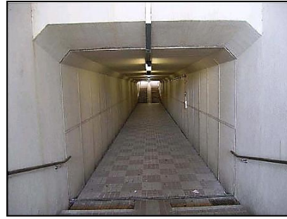
〈本栖地下道〉 （国道139号 富士河口湖町本栖）
