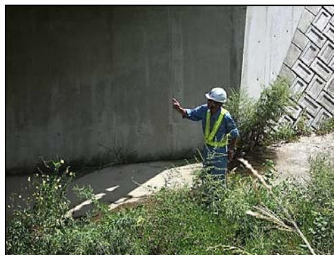
〈道路施設の定期巡回〉
