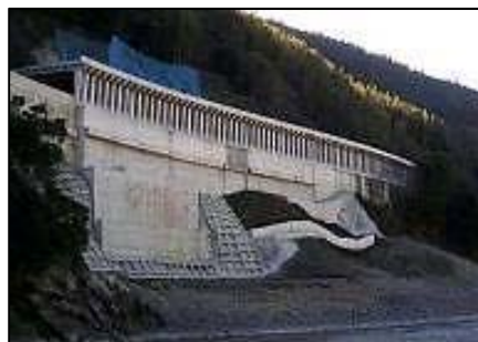
〈切久保洞門〉 (国道52号 南部町切久保)
