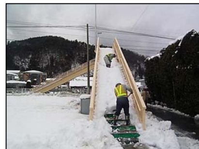
〈歩道橋 人力除雪〉 (小沼歩道橋)
