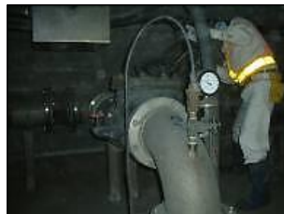
〈道路排水設備（機能点検）〉
