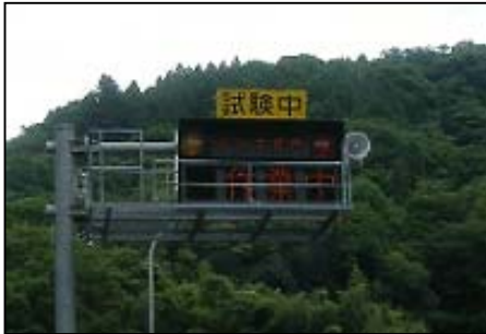
〈身延トンネル〉 （国道52号 南巨摩郡身延町）
