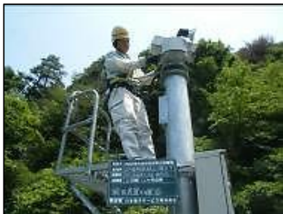
〈CCTV（機能点検）〉
