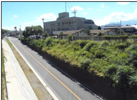
〈除草（法面）実施前〉
