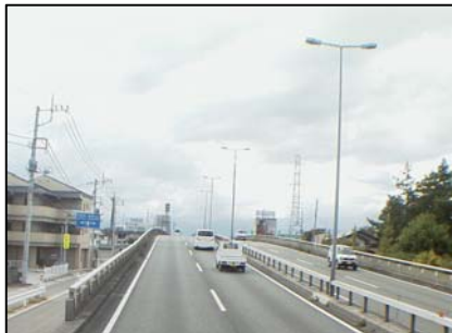
〈道路照明〉 （国道20号 甲府市精進立体）
