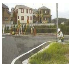
現況測量の実施
