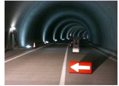
【写真5】トンネル内 仮設安全設備状況
