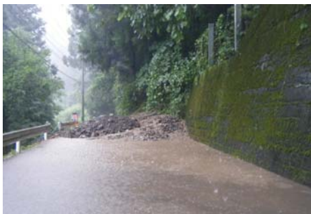
【写真1】平成22年7月14日 土砂崩落
