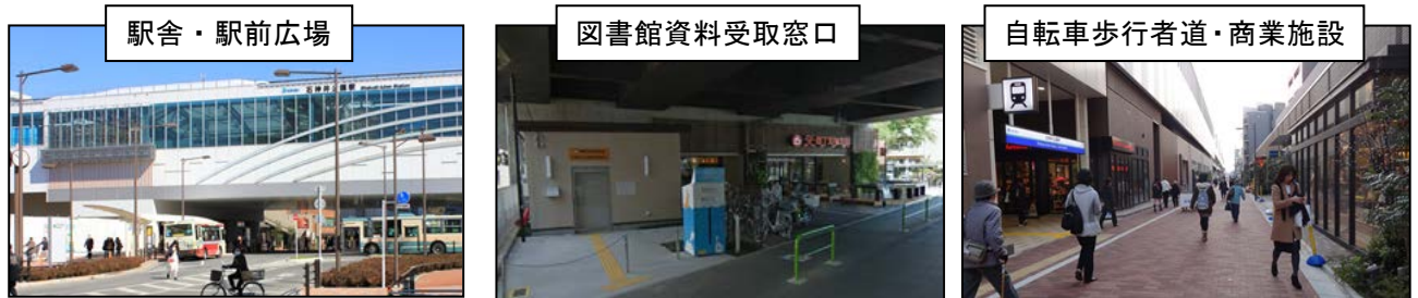
写真－2 石神井公園駅付近整備状況
