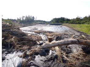
大金沢本川堆積工
