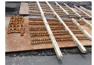
施工に使用したビット
