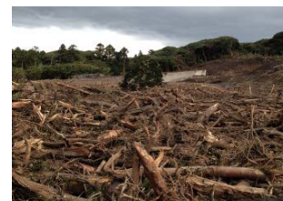
長沢本川堆積工
