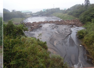
八重沢堆積工
