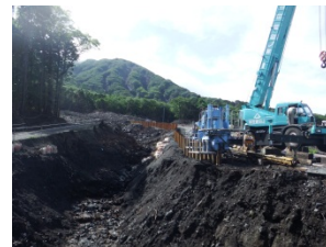
仮設導流堤施工状況
