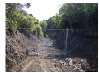
強靱ワイヤーネット工法施工完了
