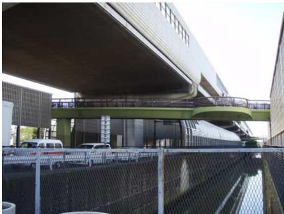
<岸川中学校前歩道橋>
