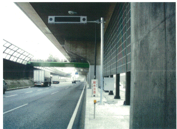
<安行地下道 冠水情報板>
