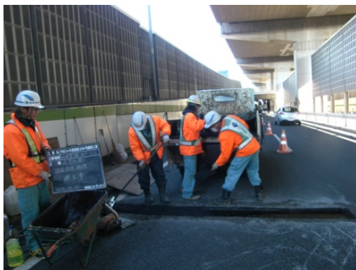
<路面段差補修>
