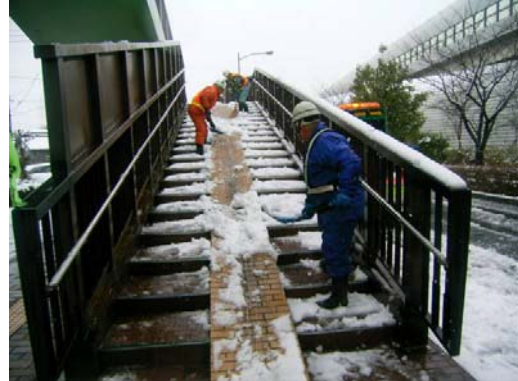
<歩道橋人力除雪>
