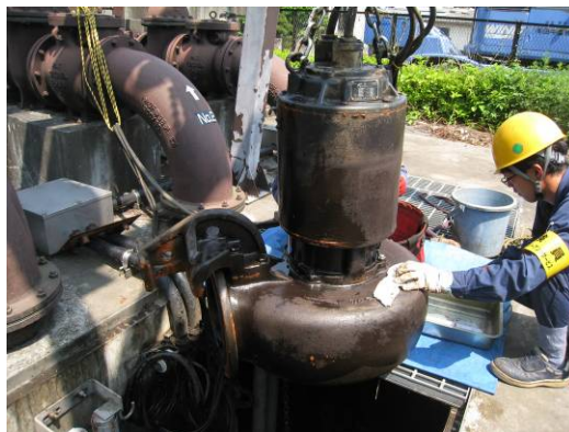
<排水設備（点検状況）>
