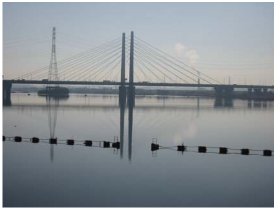
<道路橋: 幸魂大橋>
