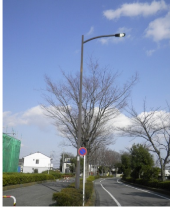
<道路照明：国道298号側道部>
