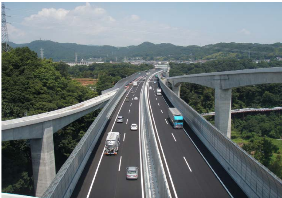
写真2 圏央道の開通状況（相模原ICランプ橋から八王子方面を撮影）
