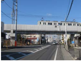
■高架化により除却された踏切
