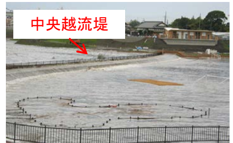
図5.中央越流堤を超えて二次池への越流
