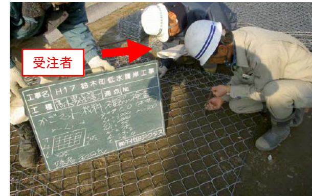
(河川護岸用かごマットの材料確認)
