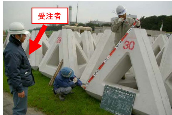
(根固めブロックの材料確認)
